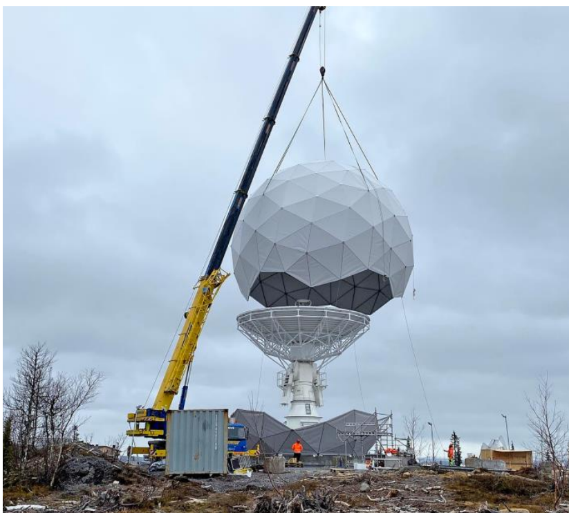
Figur 8. Slutmontering av en antenn med radom.
